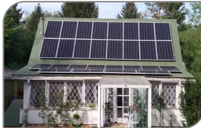
Pócsmegyer 6 kWp Mono Napelem Rendszer, 6,6 kW Tartóval
